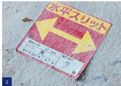
2 緩衝材となるスリット材の施工箇所をシールで示し、ミスを排除
