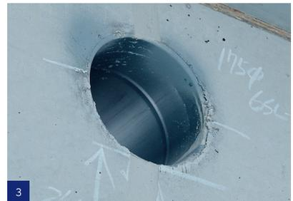
3 コンクリート打設後のスリーブの状況を目視で確認
