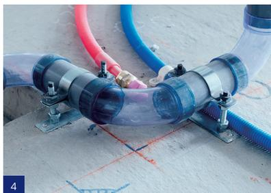
4 配管の接続や接着状況を確認できるよう継手を透明化
