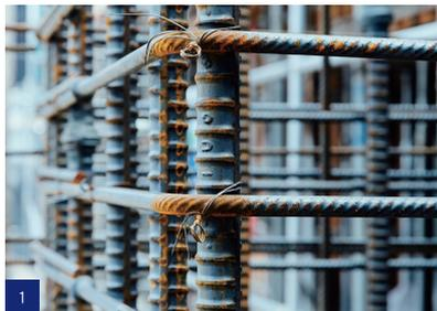
1 コンクリート打設前の配筋状況が適切であるかを確認
